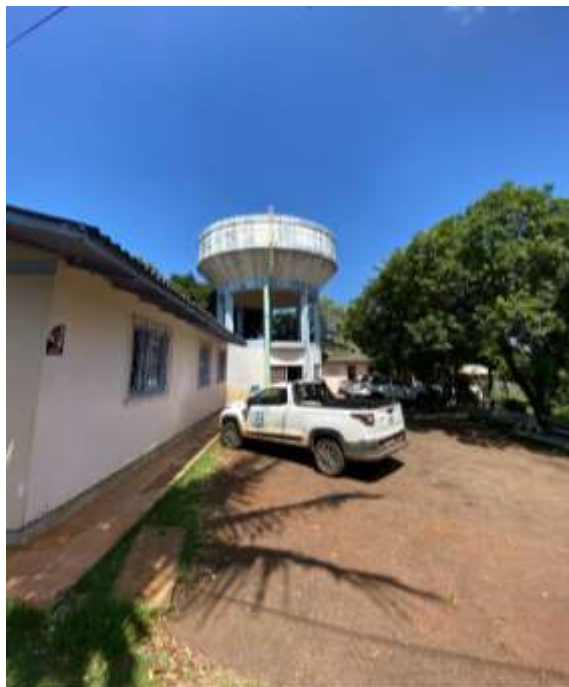
Figura 21: Reservatório central de água tratada (R-01).
