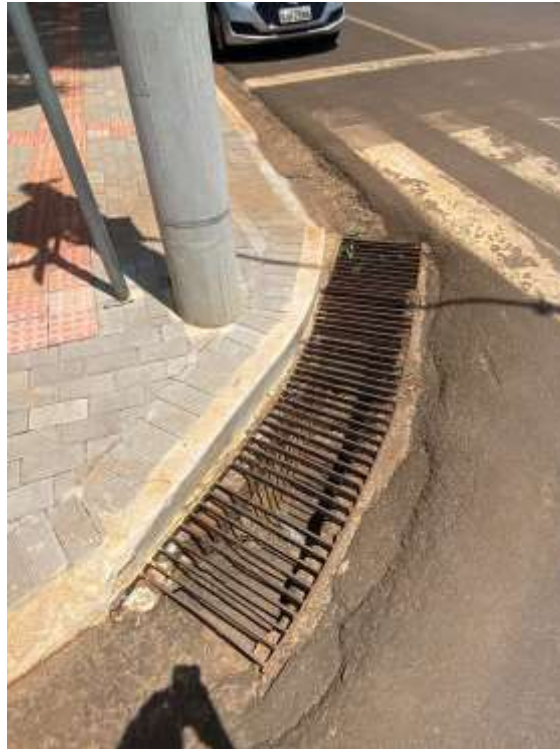
Figura 45: Boca de lobo tipo grelha estendida.
