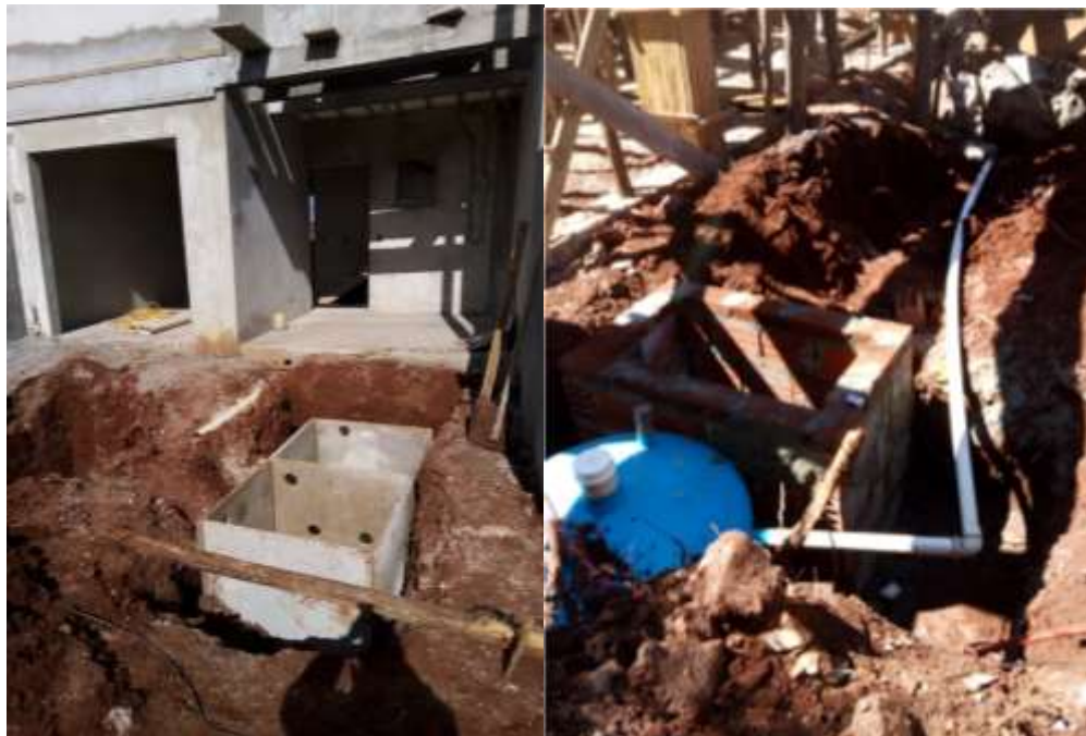
Figura 43: Sistema fossa-filtro-sumidouro.
