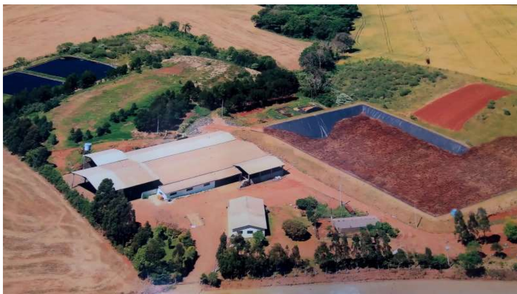
Figura 55: Vista parcial das instalações e estruturas do CONIGEPU.
