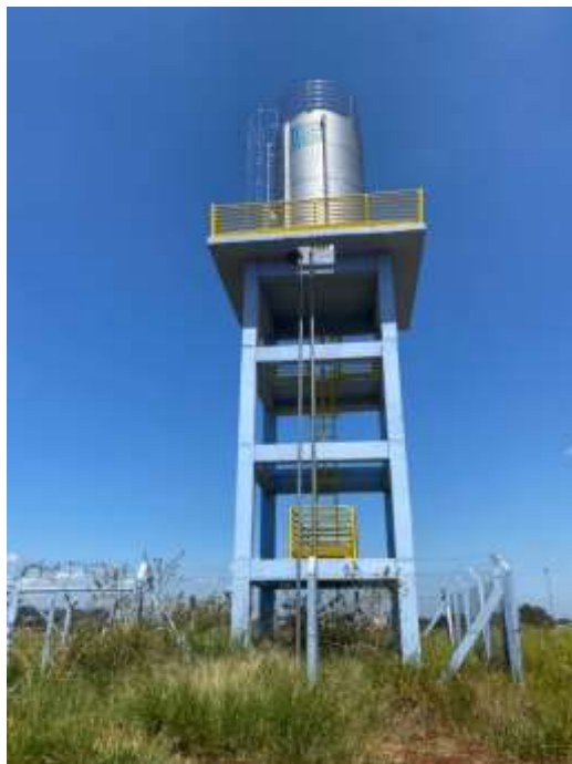
Figura 24: Reservatório Nilo Tozzo.
